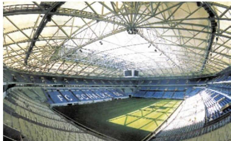
Stadiondach der Veltins Arena in Gelsenkirchen
